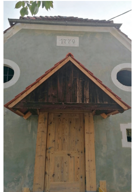
Im Rahmen der Dachdämmung wurde auch das Vordach neu eingedeckt und eine neue Holz-eingangstür eingebaut.
